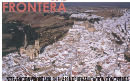
INTERVENCIÓN PRIORITARIA EN EL ÁREA DE REHABILITACIÓN CONCERTADA ARC ARCOS DE LA FRONTERA
